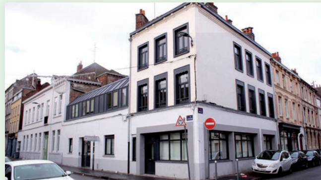
Façade du CMP Lille Sud Wazemmes 59g23
